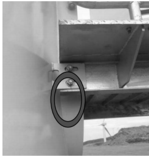
图7 塔外梯与塔壁螺栓孔紧固
