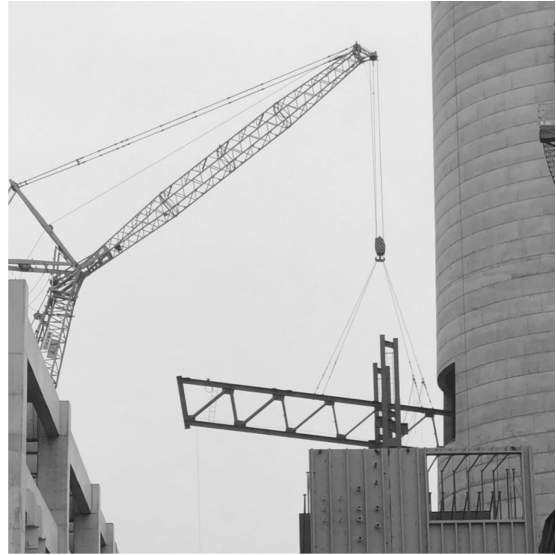
图 1 260T 吊车起吊
