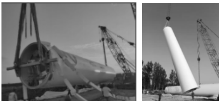
图 3 两车抬吊塔筒
