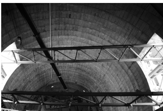
图5 第二片钢行架吊装
