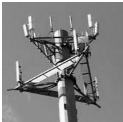
图 10 地面系统中的远程接管系统实物图
