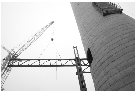
图4 第二片钢行架吊装
