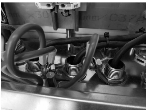
图 3 终端增加接地环
